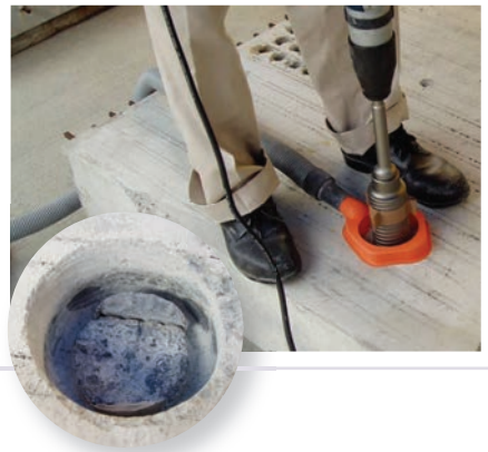
2- Extraemos el punzón cuando la corona haya penetrado levemente.
